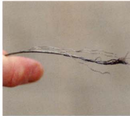
1. Los cables deteriorados deben reemplazarse de inmediato.
